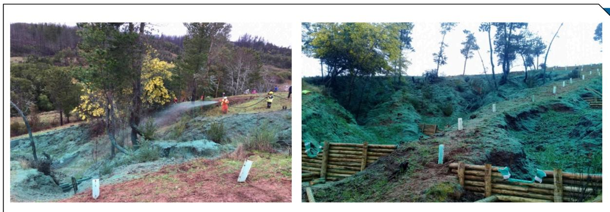
Figura 7. Aplicación de hidrosiembra en una superficie de 960 m<sup>2</sup>
