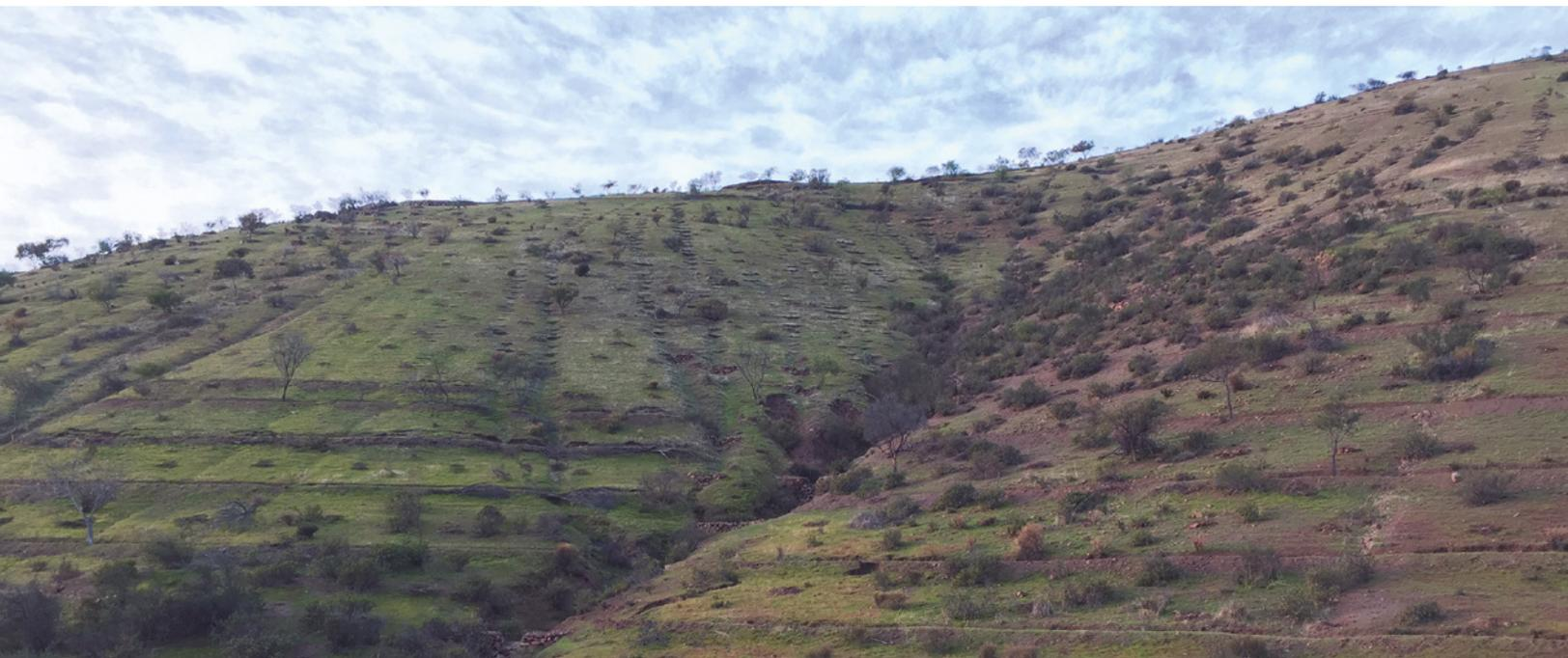
**Figura 12.** Cerro Esperanza en la Comunidad Agrícola de Cerro Blanco. Se pueden observar zanjas de infiltración y canales de desviación construidos transversalmente a la ladera, cuyo objetivo principal es disminuir el escurrimiento superficial de las laderas.
