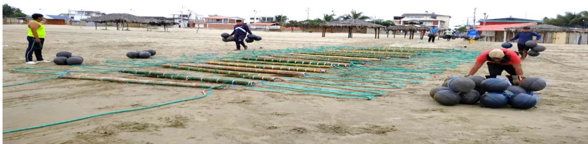
Fotografía: Diseño de las líneas de cultivo de macroalgas y moluscos en el mar por ESPOL, elaboración e instalación en el mar en Palmar por COOPROACMAR (REM, 2020).
