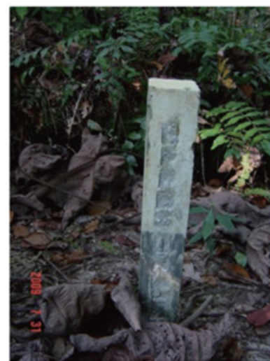
Figura T13-2 Ejemplo de estacas resistentes contra disturbios (de concreto)
