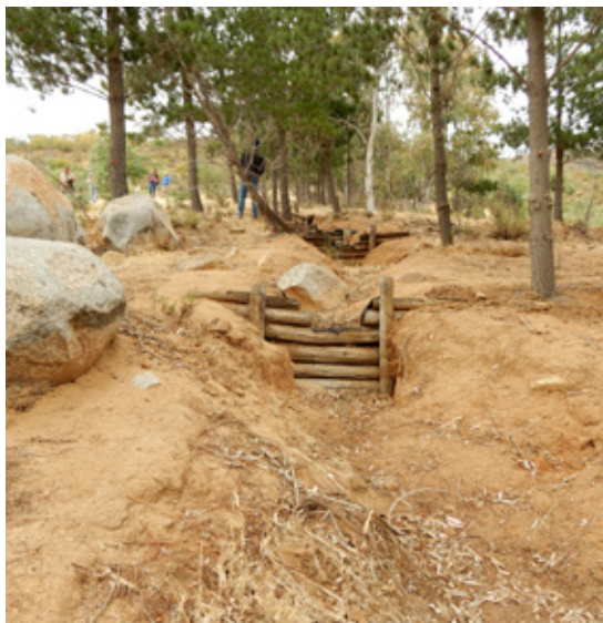
Fotografía 1. Detalle de una de las estructuras utilizadas para reducir la velocidad de escorrentía del agua y controlar la erosión. Créditos: Carolina Murcia.
